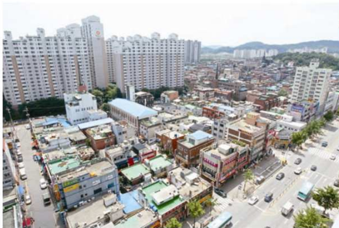
△사업이 활발하게 진행 중인 광명역 사거리 일대 뉴타운 지구 전경. <매경DB>
