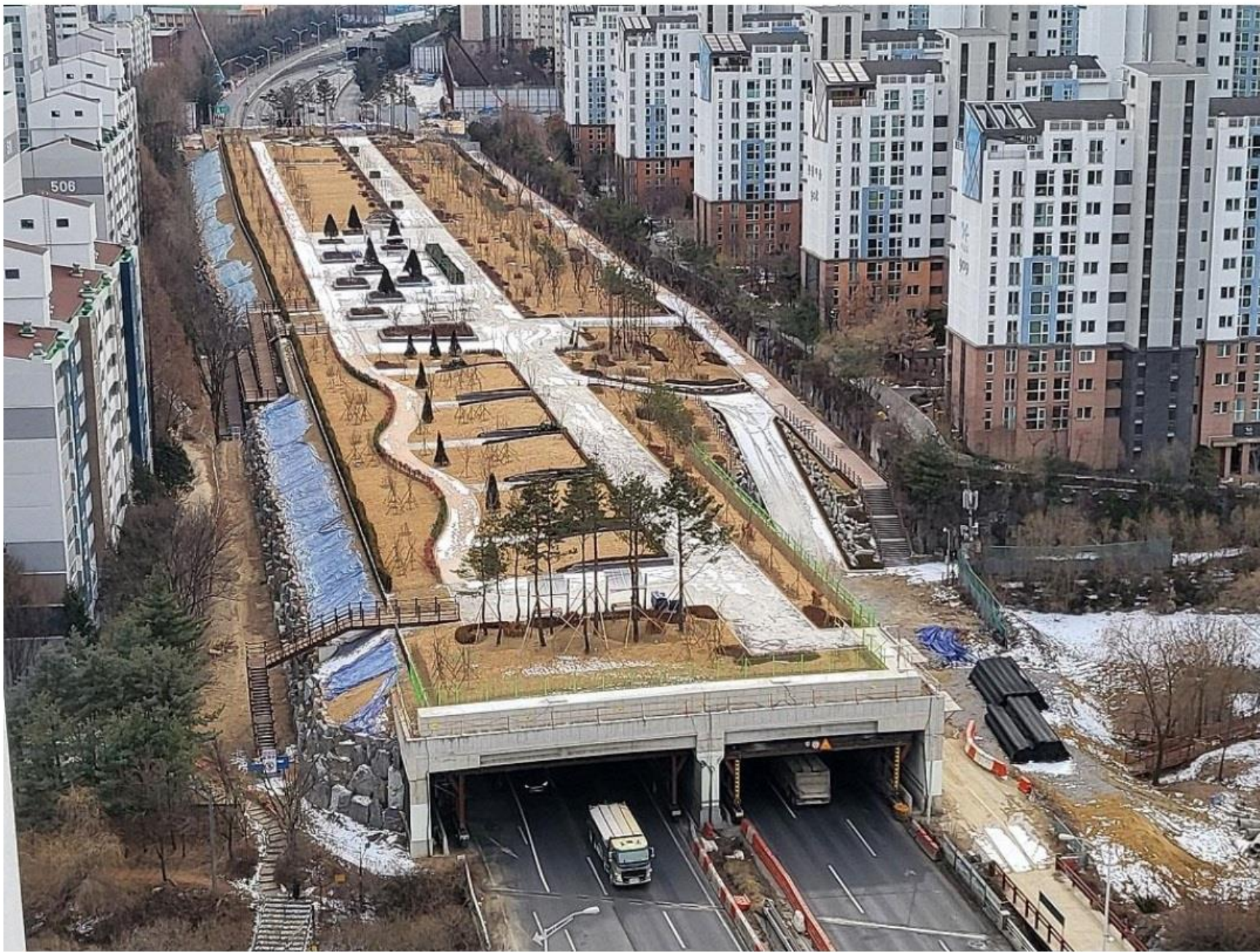
상부 공원화 공사 중인 분당~수서 도시고속화도로
